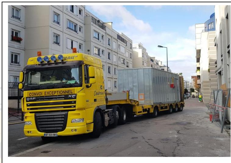
**Composition de la solution** : Une chaufferie préfabriquée de 240 kW Carrosserie en ALUMINIUM MO
