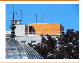
Particularité : Une chaufferie préfabriquée en toiture de 1078 kW Carrosserie en ALUMINIUM MO isolée (25mm)
