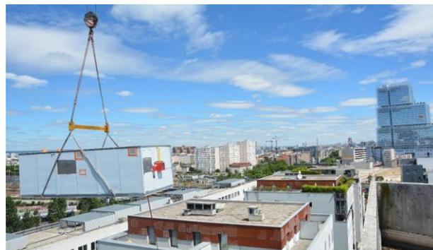
**Composition de la solution** : Une chaufferie préfabriquée de 1152 kW Carrosserie en ALUMINIUM MO
